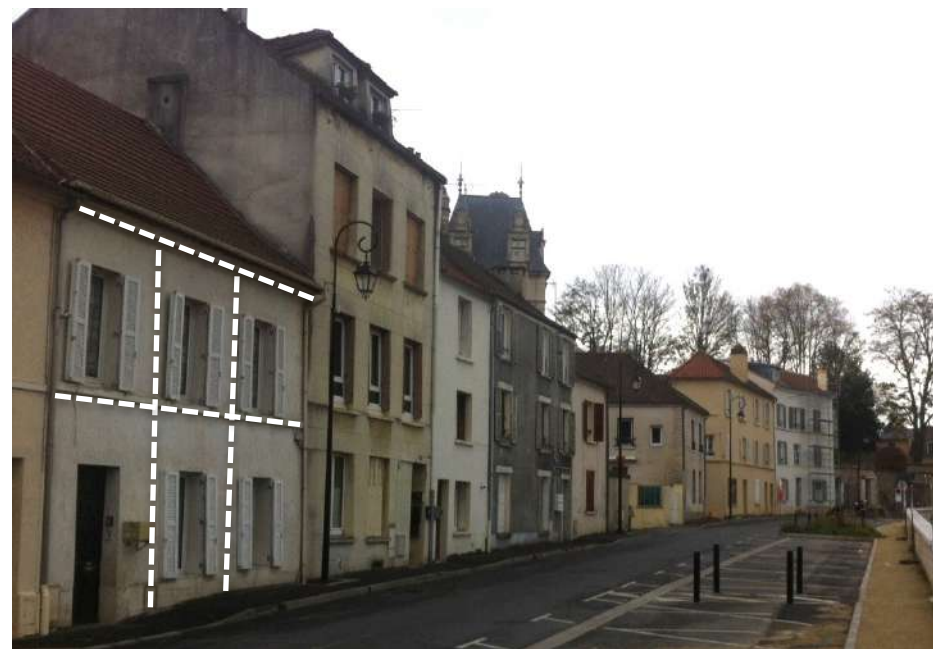
Illustration des caractéristiques des ouvertures des maisons de bourg : baies plus hautes que larges, alignements horizontal et vertical des ouvertures → à préserver
