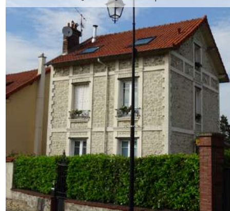
Pavillon à façade symétrique
