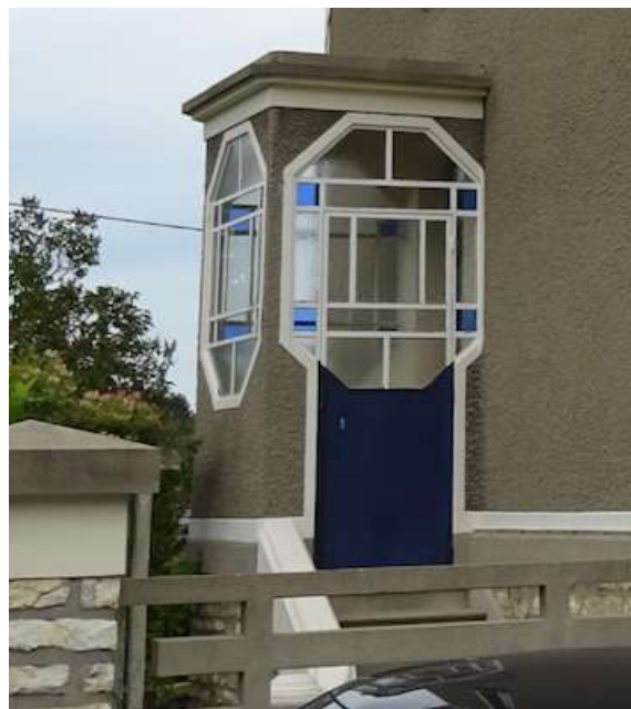
Exemple de sas d'entrée avec escalier et imposes vitrées → à préserver
