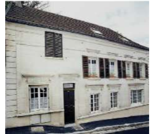
10 rue Jacques Yvon Maison et carreaux peints du peintre F.J Gardon
