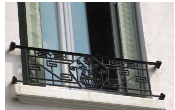
Exemple de volets en fer traditionnels repliables en tableau → à préserver
