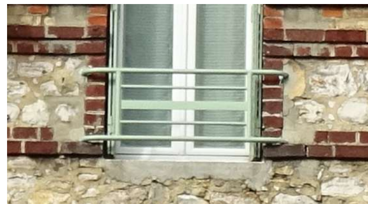
Exemples de garde-corps, illustration de la diversité de ces éléments sur les maisons traditionnelles → à préserver
