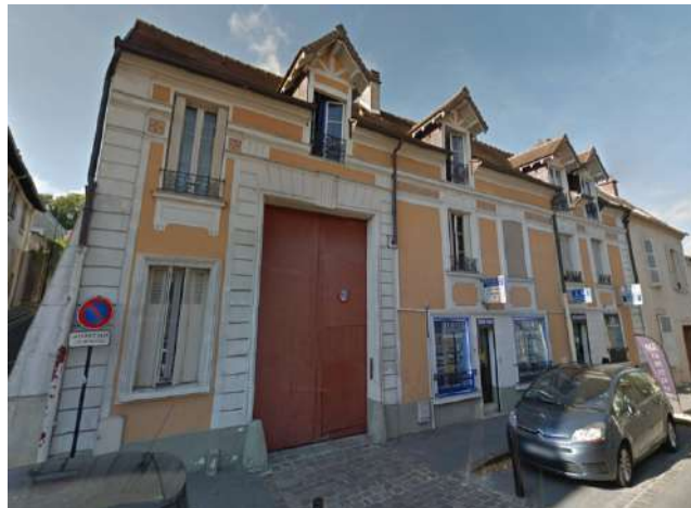
13 rue Paul Lorillon Immeuble très ornementé, bâti pittoresque
