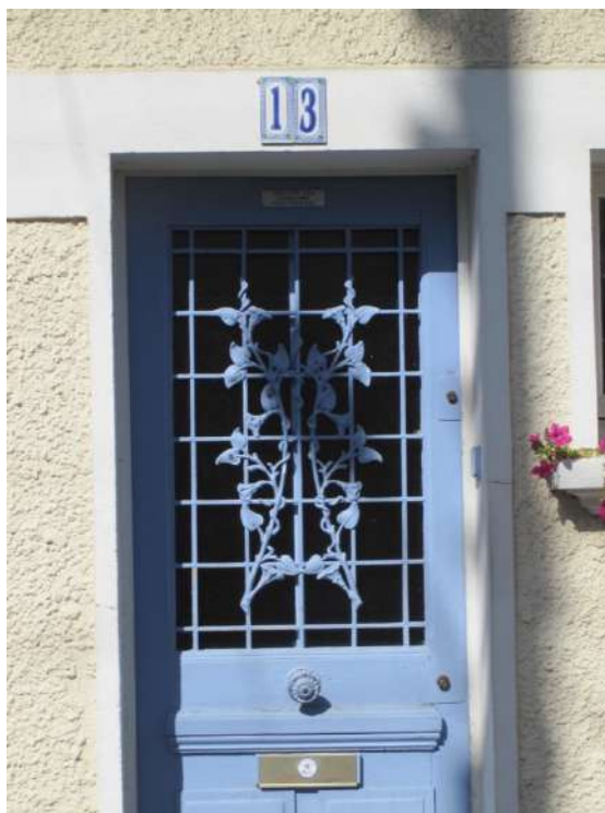
Exemple de porte d'entrée ancienne, avec impose vitrée et ferronnerie → à préserver
