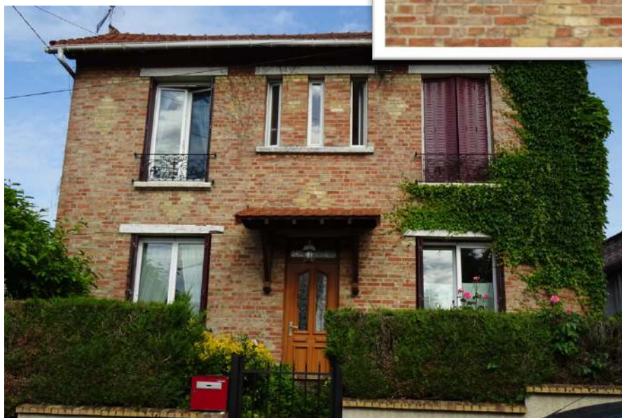
Exemple de façade en brique à préserver
