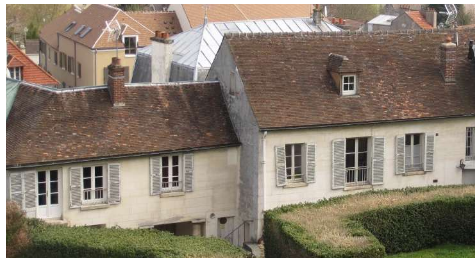
Exemples de toitures anciennes à deux pans couvertes en petites tuiles plates → à préserver
