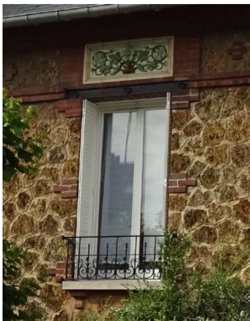
Exemple de volets en fer traditionnels repliables en tableau → à préserver
