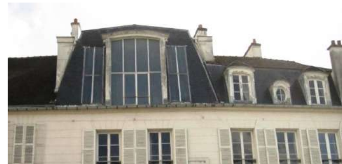
Exemple de verrière en toiture d'un ancien atelier d'artiste → à préserver
