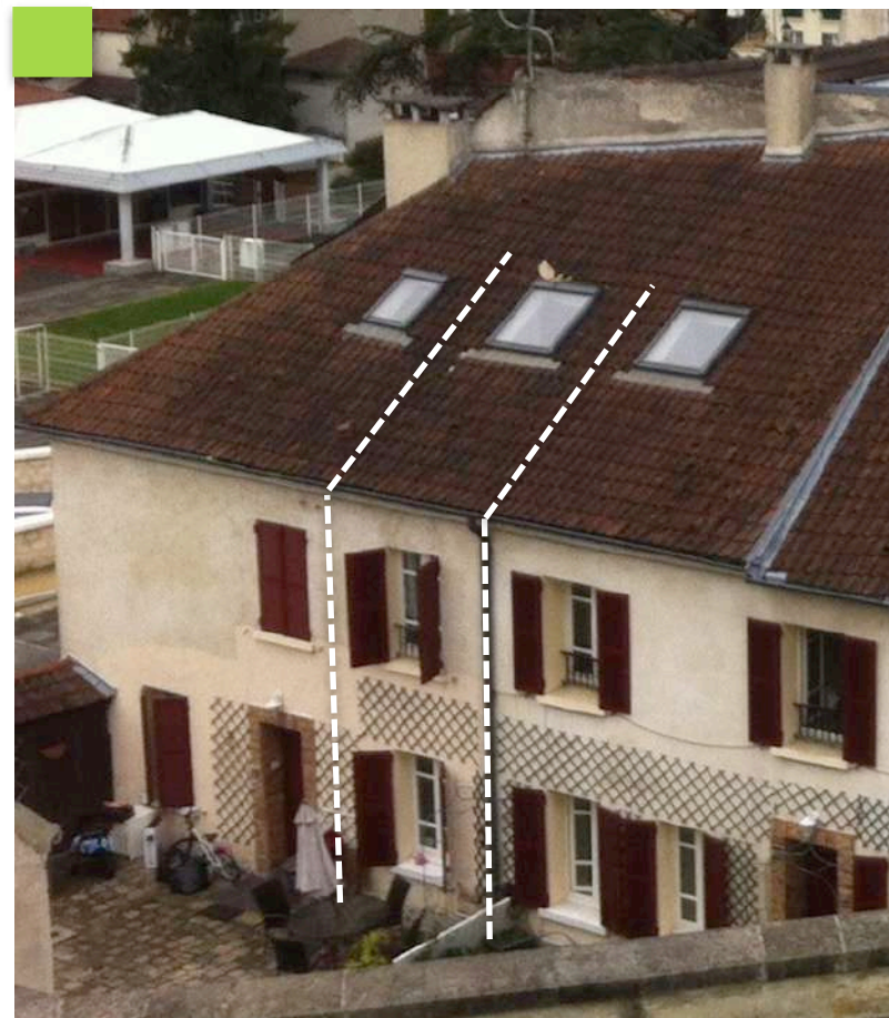
A favoriser : exemple de châssis de toit axés sur les alignement de fenêtres existantes
