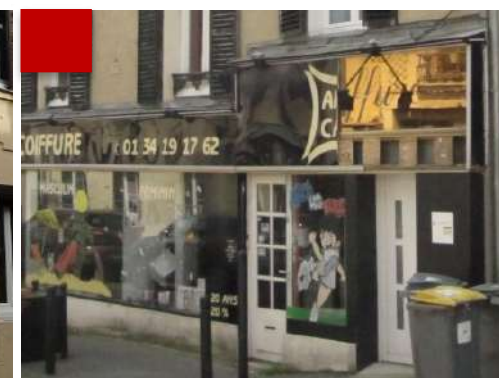
A éviter : exemple de devantures commerciales peu adaptées à une construction ancienne
