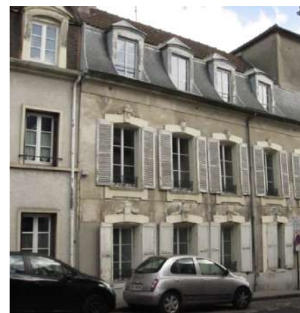
Exemple de toiture avec combles brisés couverte en ardoises et tuiles → à préserver
