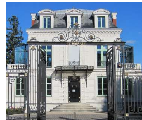
Exemple de toiture avec comble à la Mansart couverte en ardoises et zinc → à préserver
